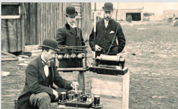
[H3] - Marconi, à esquerda, em testes no BPO usando o oscilador de Righi em 1897)
