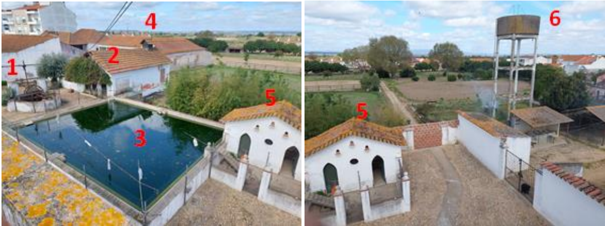
1- Nora; 2- Casa das máquinas; 3- Lago dos patos; 4- Chaminé da sala das baterias; 5- Casa de arrumos; 6- Reservatório de água.
