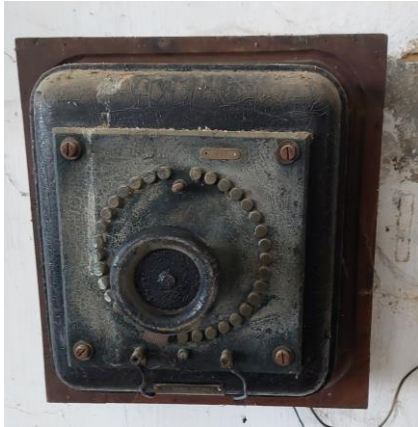
Reóstato de potência e seletor duplo coaxial usados no controlo da tensão a aplicar à bateria e a receber desta. Pormenor do barramento de condutores que acediam às baterias.
